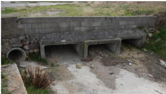
Figure 10 : Passage busé du Valaury sous la RD613 - Diagnostic hydromorphologique étang de Thau Étude no 11356 – Mars 2024
