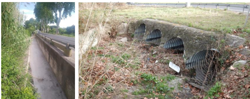
Figure 11 : Ouvrages peu adaptés le long de la Lauze : à gauche : canal bétonné le long de la RD2E5 - © Ecovia 2025, à droite passages busés de la Lauze sous la RD613 - © Diagnostic hydromorphologique étang de Thau Étude no 11356 – Mars 2024
