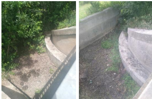
Figure 13 : Ouvrage brise-débit sous la voie-verte, à gauche la partie en amont et à droite la partie en aval, Ecovia – 2025
